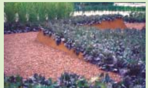
Verbau von Cortenstahl
