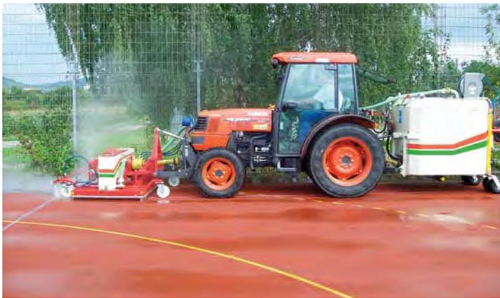
Die Schichtdicke einer Kunststoffbelages für Sportanlagen muss mindestens 13 Millimeter betragen, mit einer Basisschicht von mindestens zehn Millimetern und einer Oberschicht von mindestens drei Millimetern.
