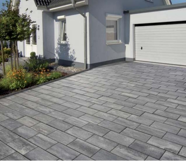
Aufgrund seiner Dicke von 8 cm und dem KANNtec10-Verschiebeschutz lässt sich Stratos-Aqua auch in Bereichen mit geringer Verkehrsbelastung, beispielsweise vor der Garage, einsetzen. Die Fläche wurde in Titangrau gestaltet.
