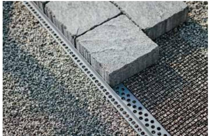
steinfix® netz ermöglicht einen besonders festen und effizienten Abschluss. Das Netz verankert sich im Splitt dank dem Eigengewicht der Platten.
