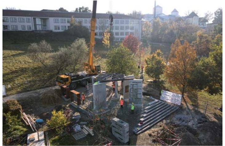
Großer Umzugstag: Aufbau des Pavillon mit fünf Betonstützen und Dach mit Hilfe eines Autokrans.
